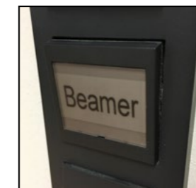
Abb. 3: Schalter an der Wand für Stromversorgung des Beamers
